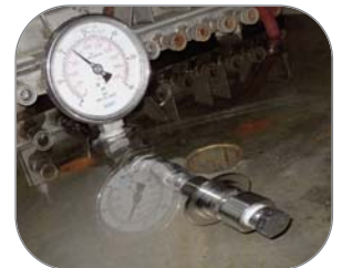
Essai pneumatique à 100 psi
